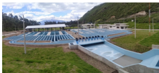
Ampliación de la Planta de Tratamiento Paluguillo - Parroquias Orientales
